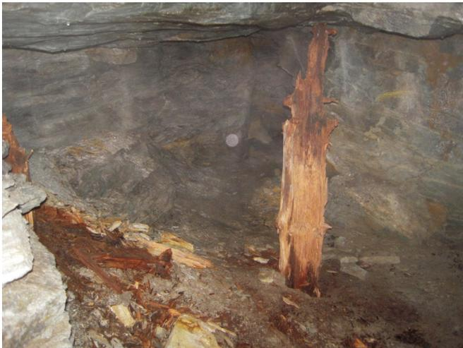
**Titel:** Stark zersetzter Stempel in der kleinen Halle des Hauptsollens, ca. 50m vom Eingang entfernt
