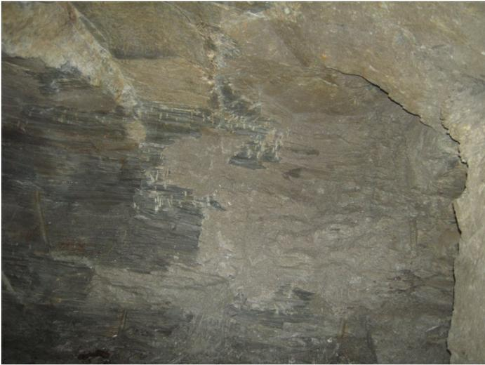
**Titel:** Nach wenigen Metern sind noch Schrämmspuren an der Sollenwand sichtbar welche auf einen abbau vor der Sprengtechnik hinweisen
